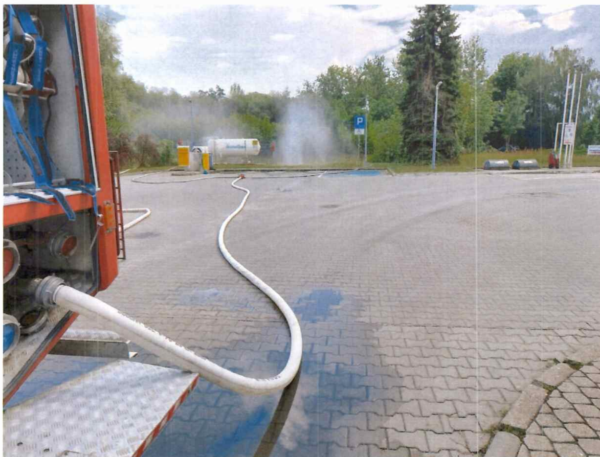
Fotografia 7 Rozszczelnienie instalacji gazowej LPG, Gliwice, ul. Rybnicka, 16.07.2024 r.
