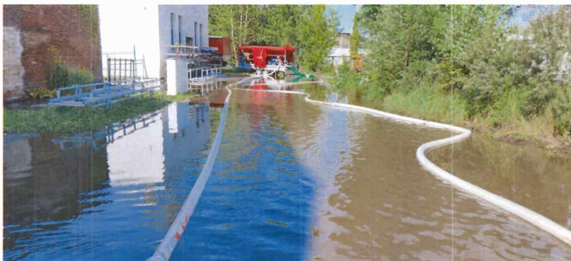
Fotografia 9 Wypompowywanie wody w Przyszowicach, 14.09.2024 r.
