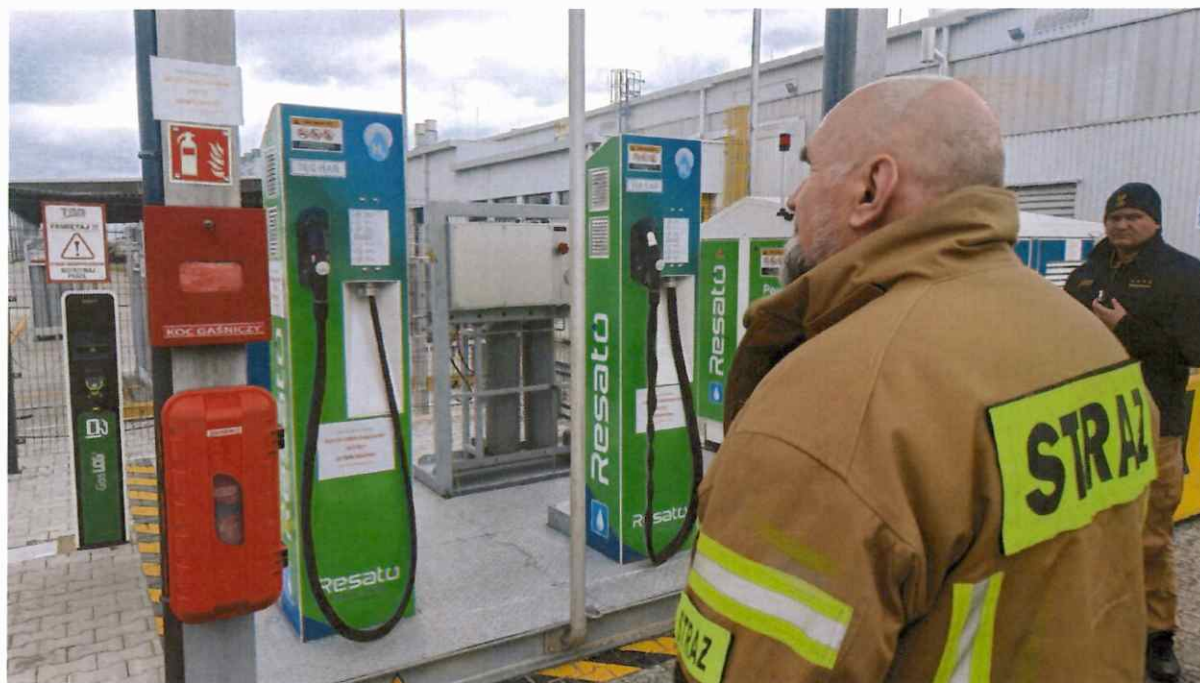
Fotografia 14 Ćwiczenia obiektowe, Stelantis, Gliwice – stacja napełniania paliwem wodorowym
